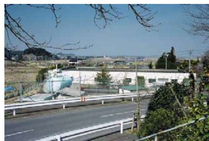
処理場・LPG 供給施設
